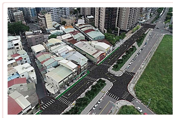
梅川南街(松竹路二段346巷至 松竹北路)拓寬工程 預計2026年2月完工
