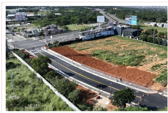
都會南街北側道路 拓寬工程完工
