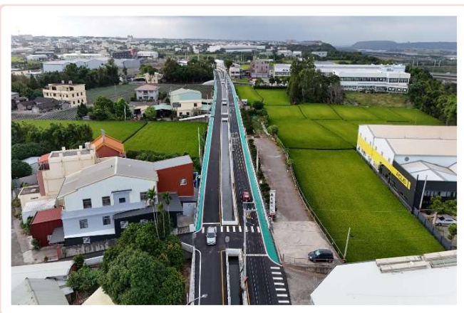
神岡區圳前路開闢工程完工 (神岡交流道至厚生路)
