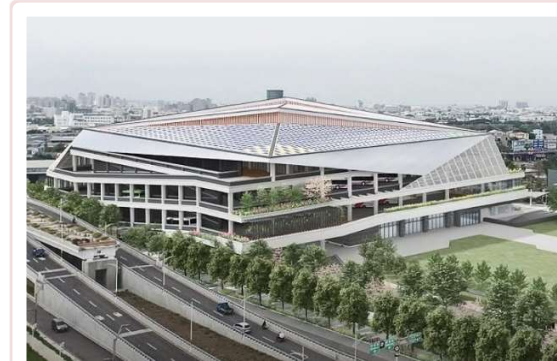
水湳轉運中心(115年2月完工) 大臺中轉運中心(預計115年底啟用)
