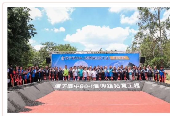
潭子區潭興路拓寬工程 2024年開工、預計2025年完工
