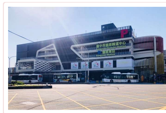
豐原轉運中心(已完工) 水湳轉運中心(預計2026年完工啟用) 大臺中轉運中心(預計2025年完工啟用)
