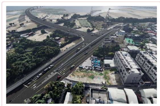
臺中大肚-彰化和美 跨河橋梁新建工程 預計2026年6月完工
