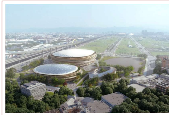
台中巨蛋2024年開工 預計2030年完工
