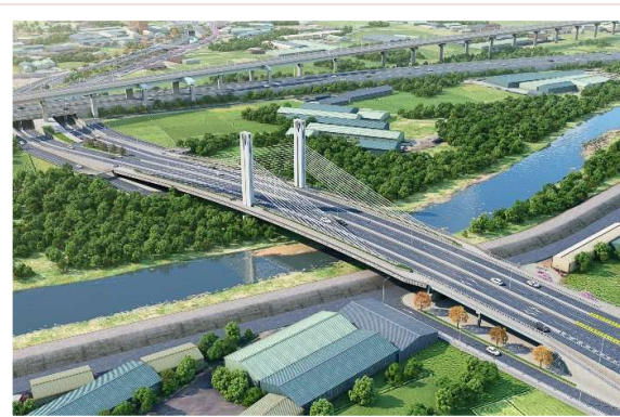
市政路延伸工程 第二標(安和路至環中路) 預計115年底完工
