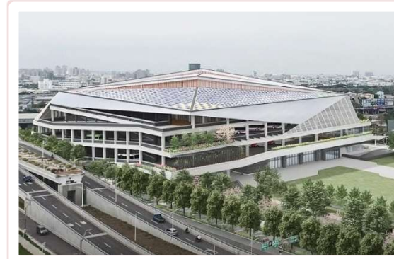
水湳轉運中心(115年2月完工) 大臺中轉運中心(預計115年年底啟用)
