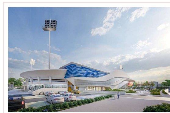
足球運動休閒園區 預計115年7月完工
