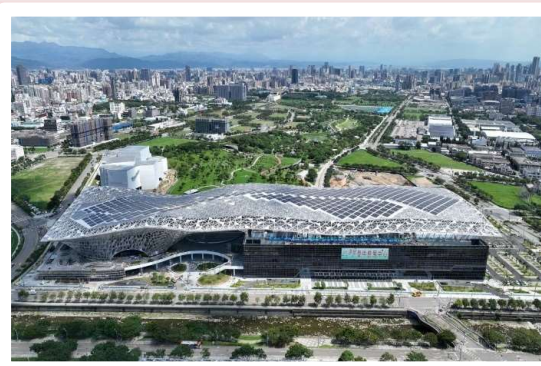
臺中國際會展中心(二期西側) 預計116年4月開工
