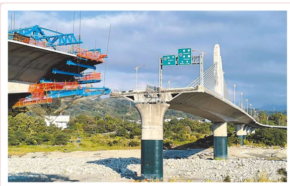
東勢-豐原生活圈 快速道路(第三標) 預計2026年完工
