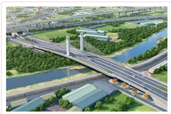
市政路延伸工程 (第二標安和路至環中路) 預計2026年完工
