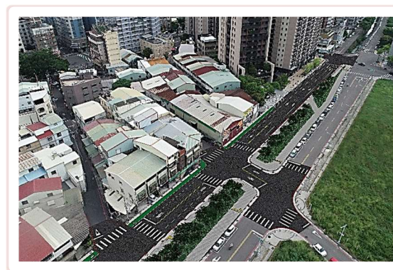
梅川南街(松竹路二段346巷至 松竹北路)拓寬工程 預計2026年2月完工
