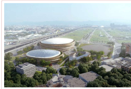
台中巨蛋2024年開工 預計2030年完工
